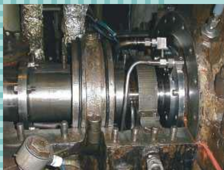
Uszczelnienie GKF w sprężarce amoniaku
