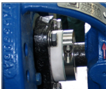
Uszczelnienie ANGA typ A10, zamontowane w wyremontowanej pompie
