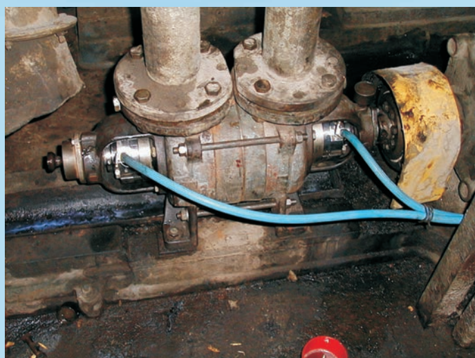
Uszczelnienie typu 22GF zabudowane w pompie S42DT prod. HYDRO-VACUUM
